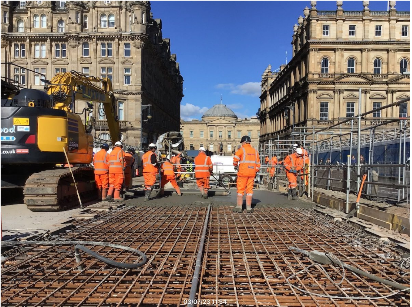
Concrete Deck pour to Bay C
